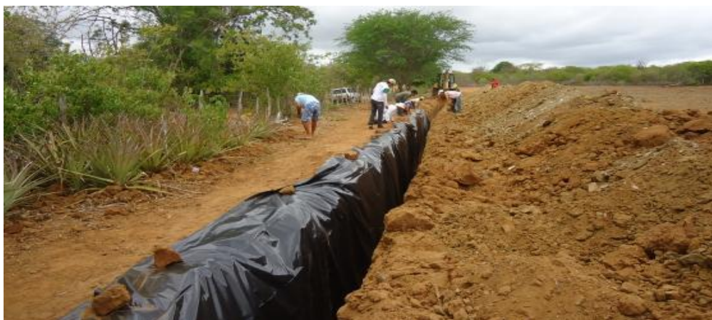
Figura 1. Estrutura física de uma barragem subterrânea.
