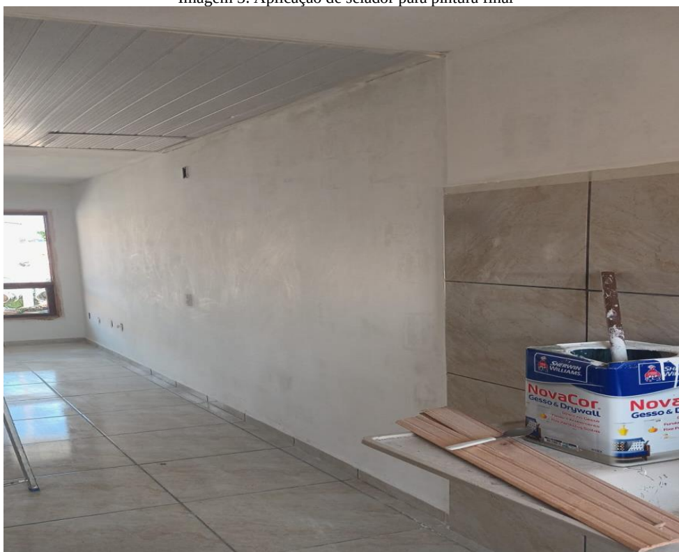
Imagem 3. Aplicação de selador para pintura final
