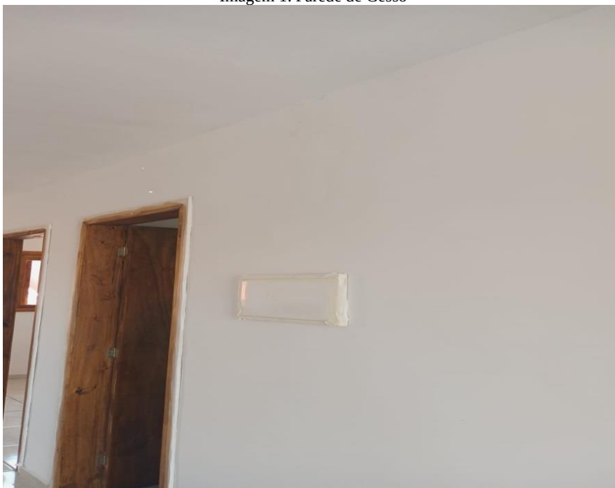
Imagem 1. Parede de Gesso
